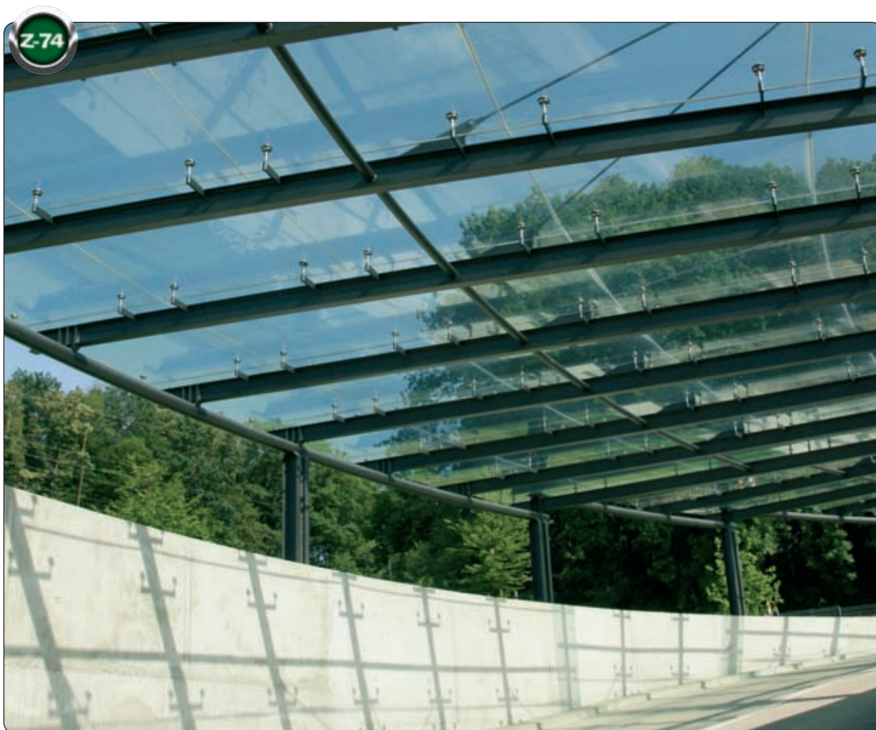
Toiture vitrée d'une entrée de parking, 2009
